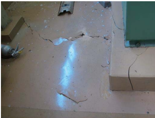
第 7.3.3 図 機械棟排風機室床面の損傷状況
