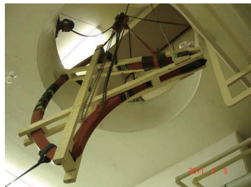
第 2.4.3 図 電磁石コイルの搬入
