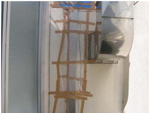
第 7.5.1 図 建家通路の亀裂破損
