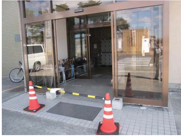
第7.4.2図 建家周辺の地盤沈下(玄関部)
