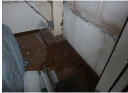
第 7.3.2 図 照射物管理棟の雨漏れ状況
