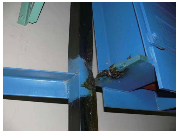
第 7.4.1 図 カウンターウエイト用レールの破損
