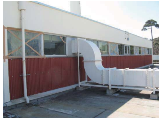
第 7.5.2 図 排風機室の窓ガラス破損
