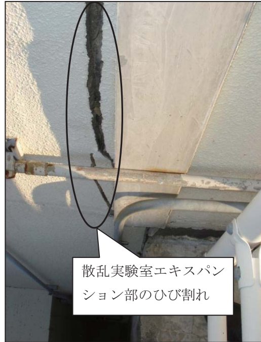
第 7.2.1 図 散乱実験室駅エキスパンション部の状況
