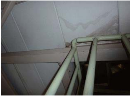
第 7.3.1 図 燃料棟天井の雨漏れ状況
