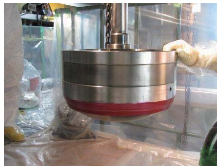
第2.1.2図 シート当たり面確認
