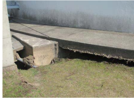
第 7.1.1 図 原子炉建家周辺の地盤沈下
