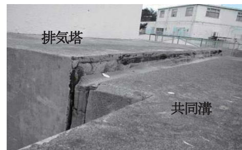
第 7.1.2 図 排気塔と共同溝の段差
