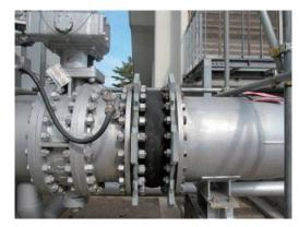
第3.1.3 図 2 次冷却系伸縮継手
