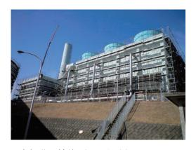
第2.1.1図 原子炉建家、排気塔及び冷却塔の補修(足場組立)
