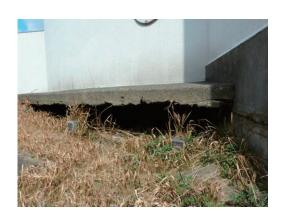
第2.3.1図 原子炉建家周辺における地盤沈下の様子
