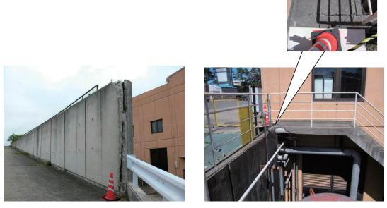
第 2.4.3 図 左: 擁壁の継ぎ目部分のひび割れたコンクリート片を取り崩した 右:  $SF_6$  ガス操作室南側の外階段の継ぎ目でひび割れが発生した
