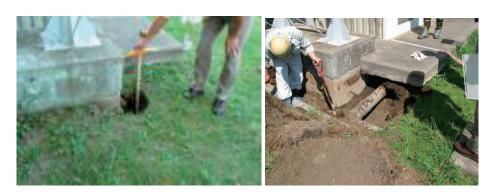
第2.6.4 図 排気筒付近の陥没と試掘調査の状況
