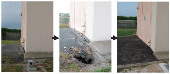
第2.6.5 図 トラック出入口の段差とその後の陥没及び補修後の状況
