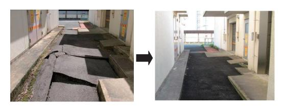
第2.5.5 図 RI 製造棟周辺地盤沈下の状況と補修後の状況
