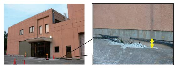
第2.4.2 図 左:建家に対して玄関前コンクリート路面が約15 cm 沈下した右:(拡大図)建家とコンクリート路面の継ぎ目
