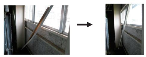
第2.6.1 図 機械室建家の変形した筋交い(鉄骨)の補修前後の状況
