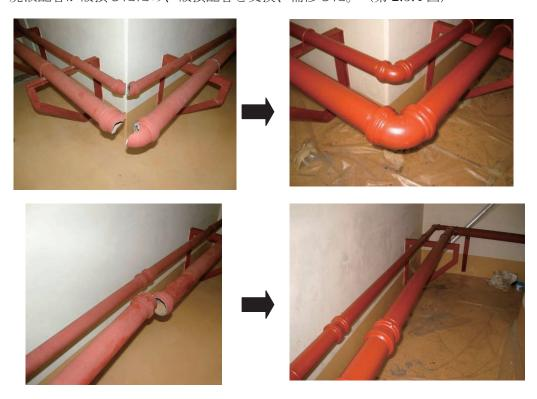
第2.5.4 図 600 エリア廃液配管の破損状況と補修後の状況
