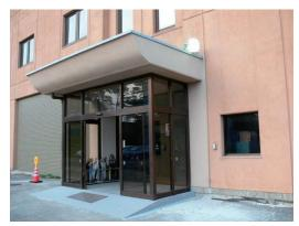
第2.4.1 図 左:地盤沈下によりタイルが破損して玄関自動ドアが浮いている右:建家側の高さに合わせて玄関を補修した
