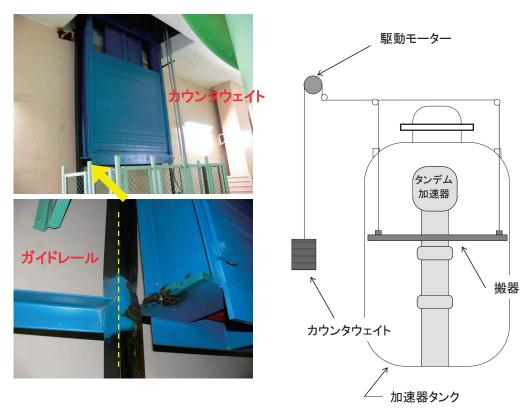
第 2.4.5 図 左:地震によりカウンタウェイトのガイドレールが破損
