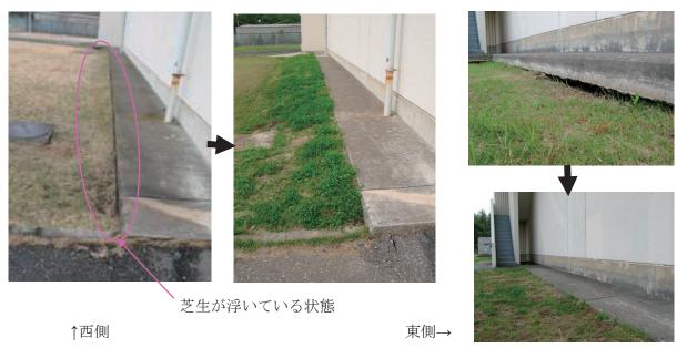
第 2.6.3 図 建家周り地盤沈下の補修前後の状況
