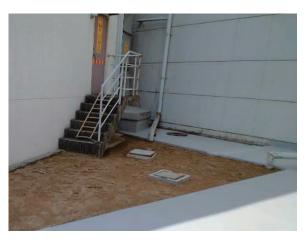
第2.1.3図 原子炉建家と実験利用棟の間の地盤沈下(補修前後)
