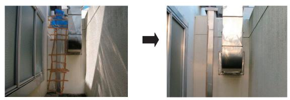
第2.5.3 図 エキスパンション部の破損状況と補修後の状況
