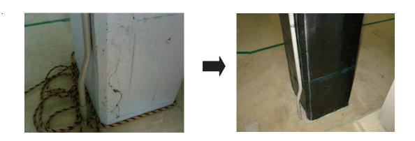
第2.5.2 図 2 階排風機室支柱の破損状況と補修後の状況
