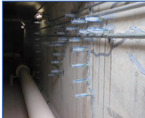
図 2.2.3 共同溝(B)エポキシ注入
