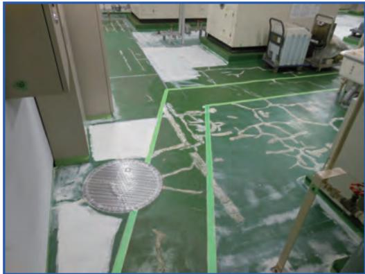
図 2.2.2 機械室床 樹脂モルタル補修
