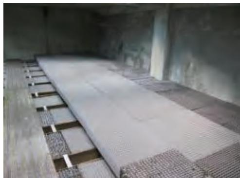
図 2.1.10 エリミネータ更新後の冷却塔内部
