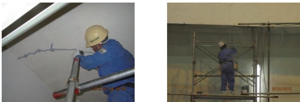
図 2.1.18 ひび割れ部の補修工事
