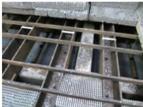
図 2.1.9 エリミネータの交換作業
