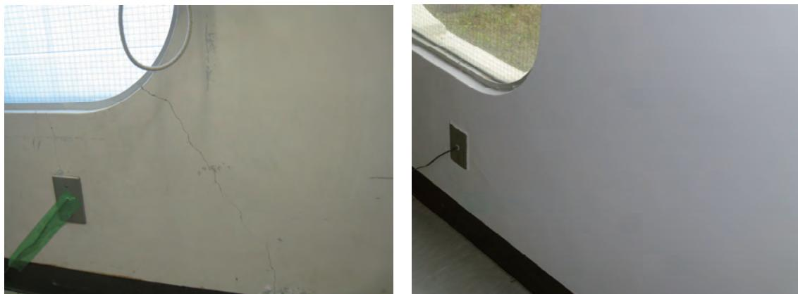
図 2.3.1 制御棟 制御室壁面の損傷及び復旧状況
