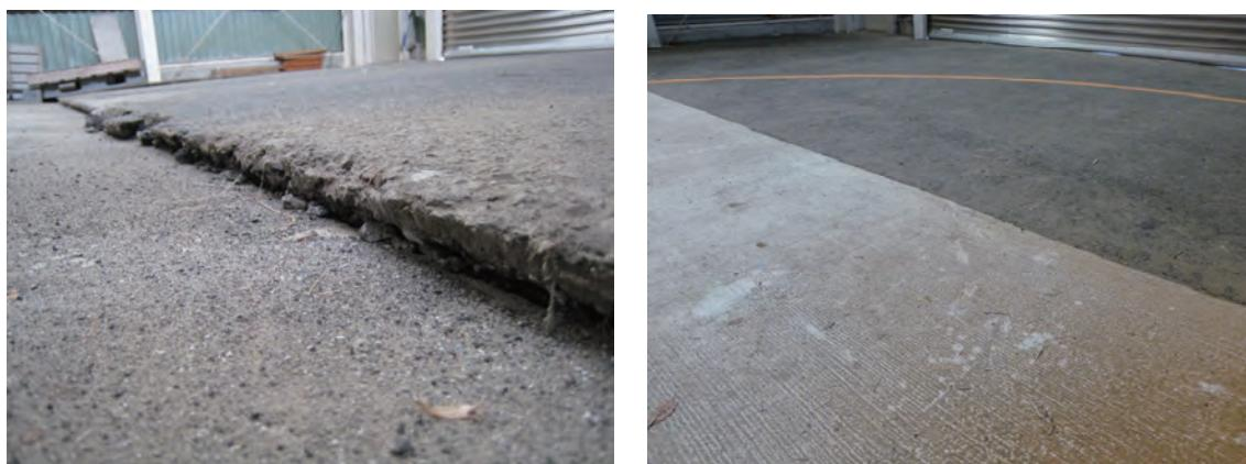
図 2.3.2 風除室 路盤の損傷及び復旧状況
