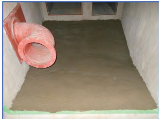
図 2.2.4 排気風洞 樹脂モルタル補修
