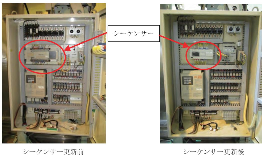
図 2.1.8 使用済燃料取扱装置シーケンサー
