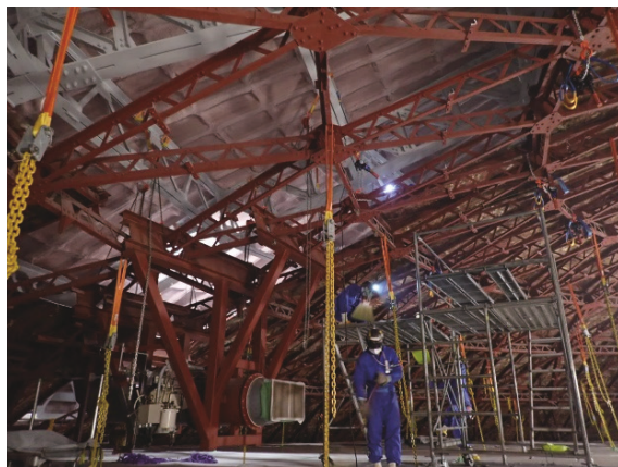
写真 2.1.17 既設屋根撤去状況
