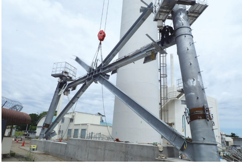
写真 2.1.12 支持鉄塔建込状況
