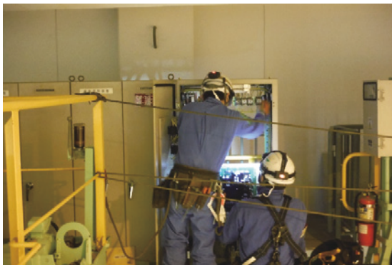
写真 3.1.2.7 主巻制御盤ユニットの取り付け
