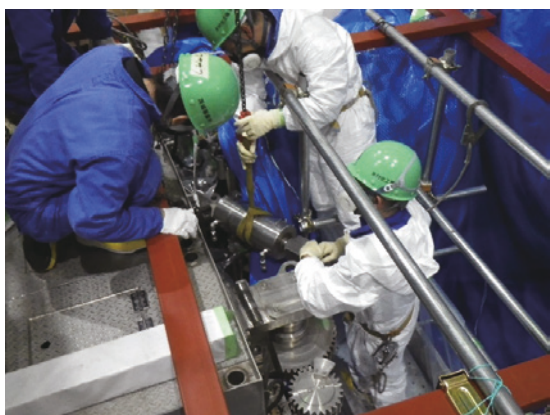
写真 3.1.2.1 駆動用水圧シリンダの取り付け
