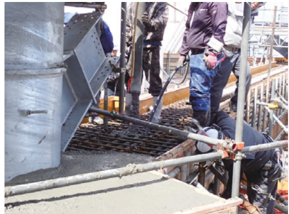
写真 2.1.11 コンクリート打設状況
