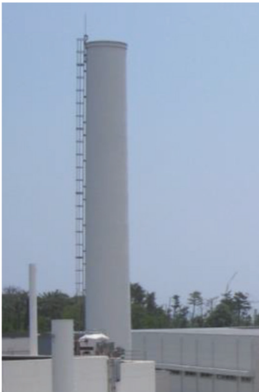
写真 2.1.13 排気筒の耐震改修工事前
