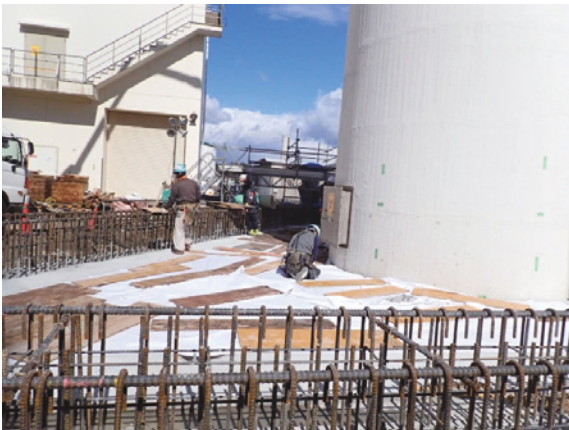
写真 2.1.10 配筋工事状況
