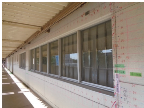
写真 2.1.20 実験利用棟開口閉塞前
