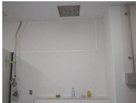
写真 2.1.7 耐震スリット完成
