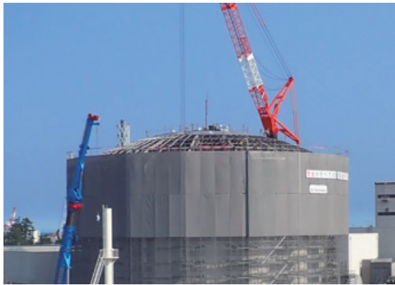
写真 2.1.15 鉄骨設置状況
