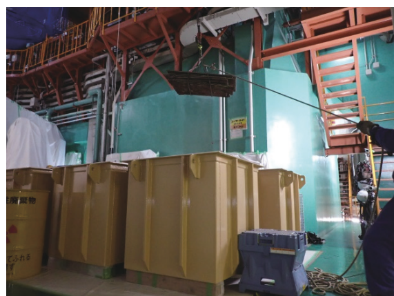
写真 2.1.18 解体廃棄物封入状況
