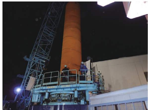
写真 2.1.9 杭鋼管打設状況
